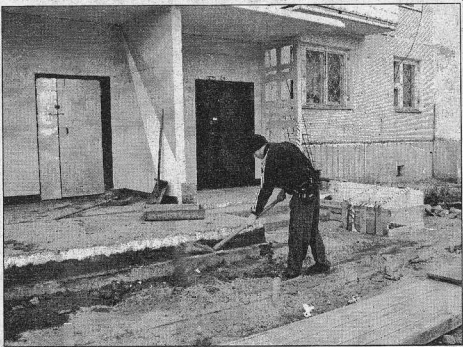
Ремонт входных групп в доме № 8 по ул. Гайнулина
