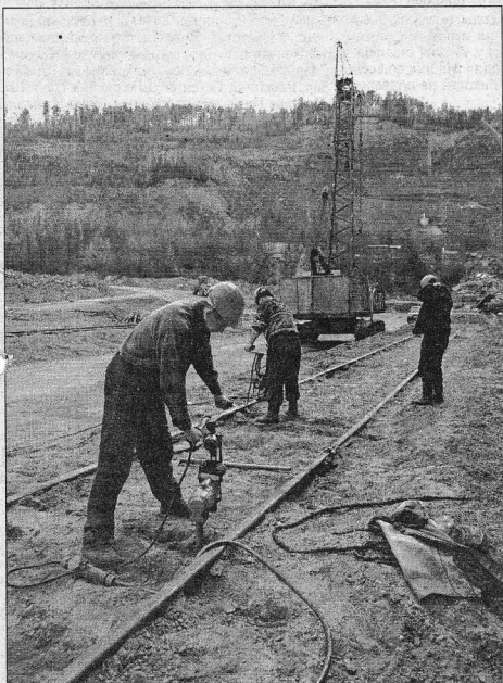
Подбивка путей для крана.
