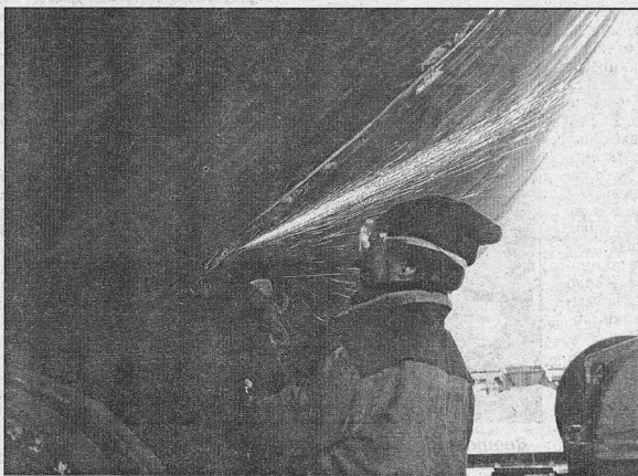
Зачистка стыков звена 9-10.
