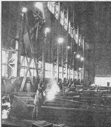
В цехе Гидромонтажа кипит работа.
