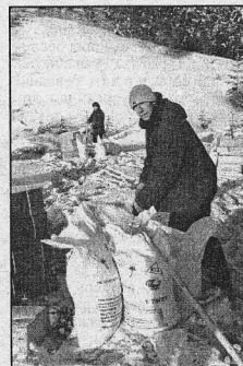
Подготовка взрывных работ.
