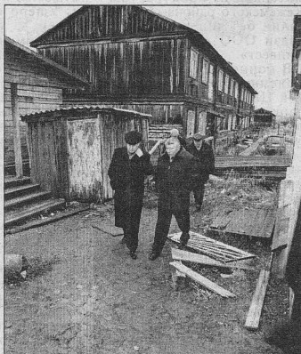
Осмотр зоны затопления. Поселок Временный.
