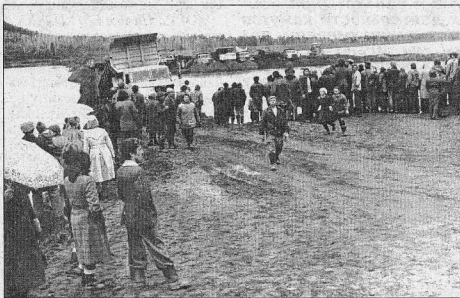
Перекрытие перемычки котлована 1-й очереди. 19 сентября 1981 г.
