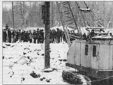
Забивается первая свая в будущем городе. 8 апреля 1977 г.
