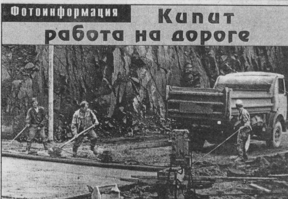
Почти на четыре километра сокращается маршрут движения автотранспорта, направляющегося из районного центра на писчерную базу по новой автодорожке Кодинок - стройбаза в районе лавобережной врезки. А это экономия горючего и времени. Потому и стараются сегодня строители ООО «Сибэлектромонтаж» из бригады возглавляемой Геннадием Васильевичем Паниным, работать так, чтобы уже к нынешней зиме по новой автодорожке поехали автомобили с различными грузами и пассажирами.
