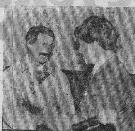
Памятный знак ветерану стройки, электросварщику Виктору Юрьевичу ШУРУХИНУ вручает управляющий треста «Гидрострой» В. А. Калабин.
