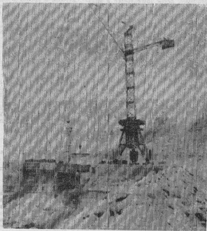
Трестом «Кодинскгидрострой» уложено в 1992 году 103,5 тыс. кубометров бетона. Начал выполнять работы кран БК-1000.
