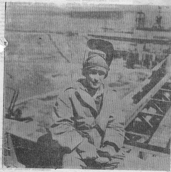
Анатолий Павлович Лысов с 1976 года на стройке, сварщик. Начинал работать в УГЭ, занимался снабжением теплом в домах временного поселка гидростроителей, возглавлял бригаду сантехмонтажников на городской площадке. С 1984 года трудится на основных сооружениях ГЭС в СМУ-5.
