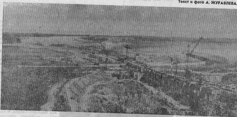
Сооружение асфальто-бетонной диафрагмы каменно-набросной плотины (снимок слева) — один из основных участков работы на ГЭС, которому руководство треста уделяет большое внимание. На снимках внизу — управляющий трестом «Богучангэсстрой» Ю. В. Сахарнов и мастер Т. В. Петренко (слева); ГЭС сегодня.
