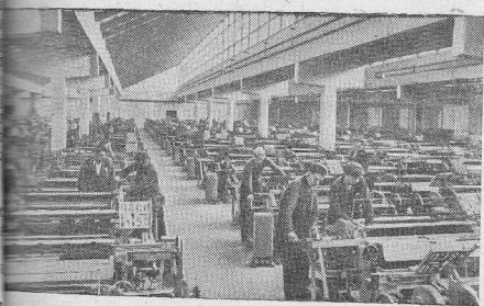
Московская область. На Наро-Фоминской пражско-ткательной шелковой фабрике строится большой ткацкий цех №4. До конца года в этом цехе будет установлено 600 многошпиндельных шелкоткацких станков. На снимке: монтаж оборудования в новом цехе. Фото Э. Евзерихина. Прессклуб ТАСС.
